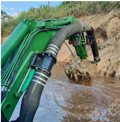
La Watermaster déblaie pour ouvrir l'accès aux autres dragues
