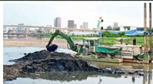
Работы по обслуживанию каналов на Берегу Слоновой Кости
