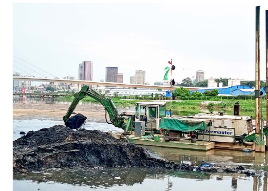
科特迪瓦的运河维护工程
