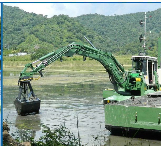
用挖掘清除淤泥和芦苇
