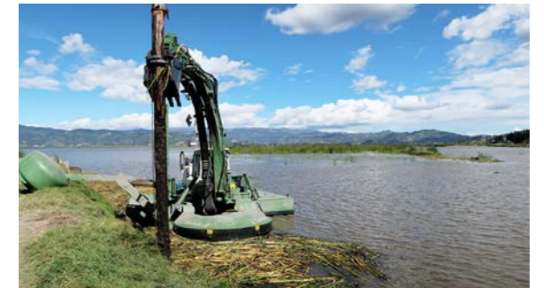
在 Fúquene 湖进行打桩作业
