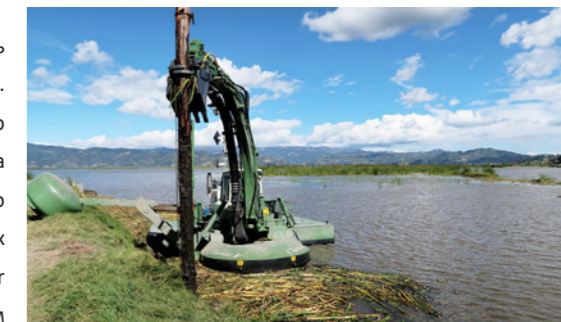
Установка свай на озере Фукуэн
