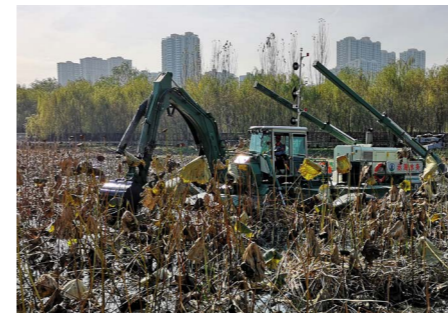
Élimination des déchets et de l'envasement par excavation
