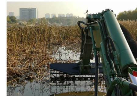
Déblayage de la végétation et des débris par ratissage
