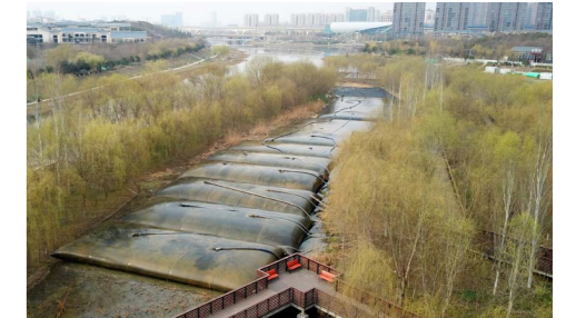
Assèchement par tubes géotextiles
