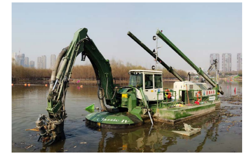
Enlèvement des boues par dragage par succion
