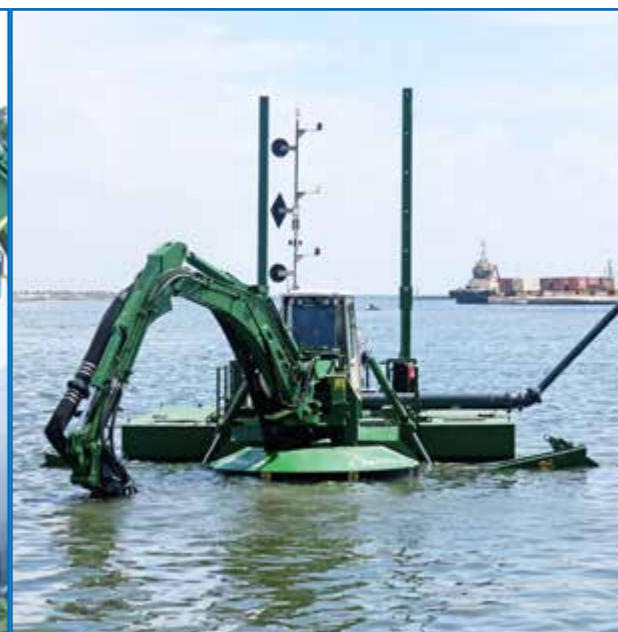
TRAVAIL EN EAU PEU PROFONDE EFFICACE ET SÛR GRÂCE À UNE MACHINE SPÉCIALEMENT CONÇUE À CET EFFET
