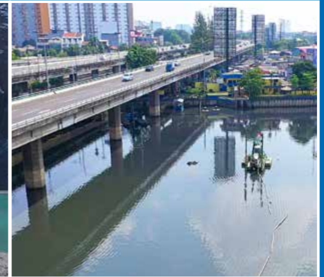
RÉSERVOIRS URBAINS DE CONTRÔLE DES INONDATIONS
