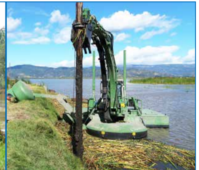
ENRAYEZ L'ÉROSION DES RIVES EN BATTANT DES PIEUX
