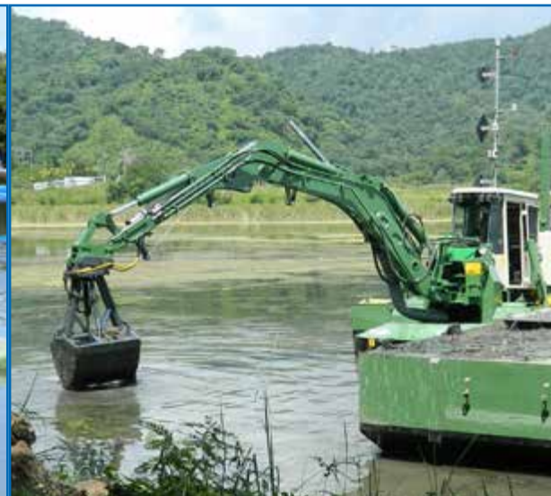
LIMPIAR SEDIMENTOS Y CAÑAS POR EXCAVACIÓN
