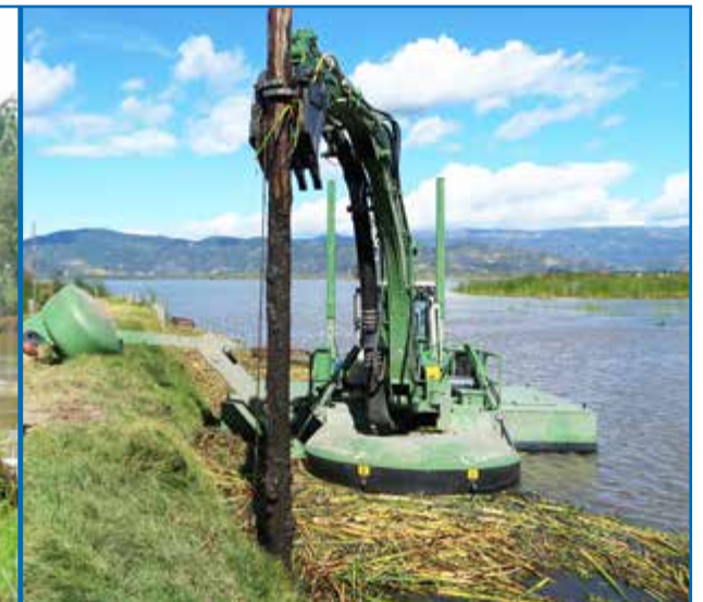
DETENER LA EROSIÓN DE LA COSTA MEDIANTE EL HINCADO DE PILOTES
