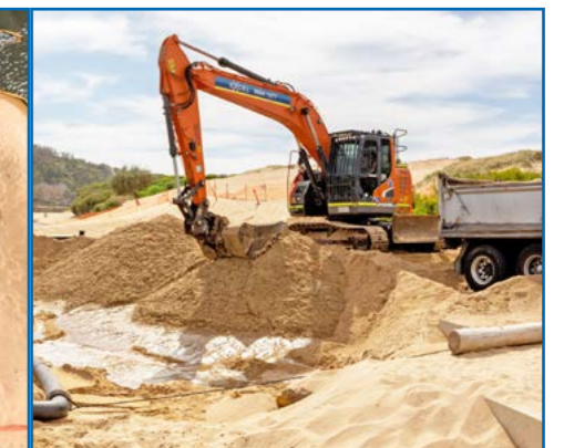
3. 挖掘机将沙子挖到卡车上，然后运到附近的海滩上
