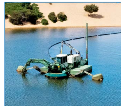
1. “水王”绞吸疏浚将累积的沙子直接疏浚至岸上
