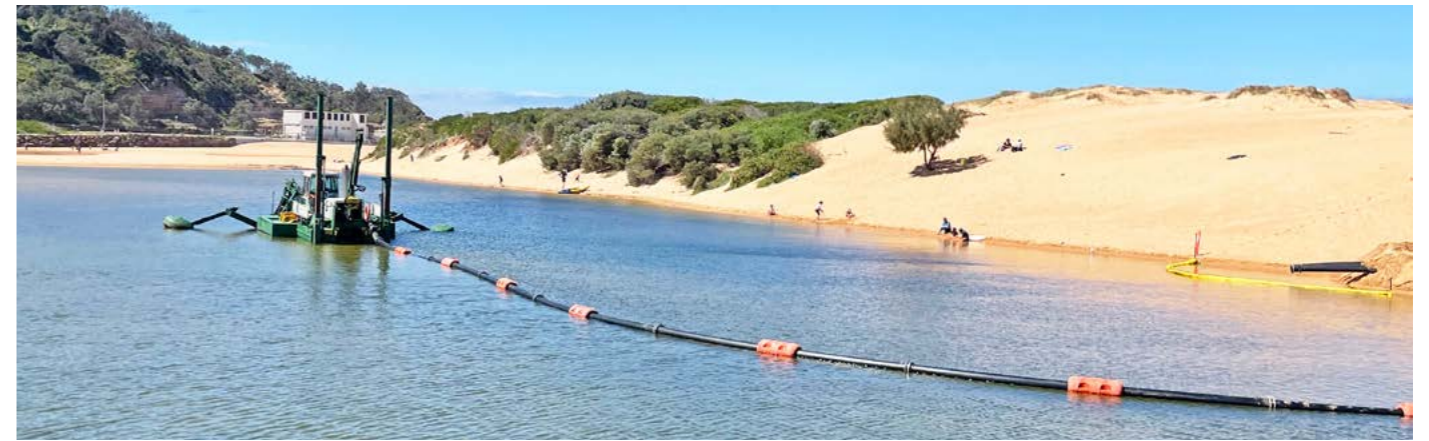
以智慧的方式保护当地社区免受洪水侵袭 “水王”挖泥船一次性将累积的沙子直接泵送到岸上
