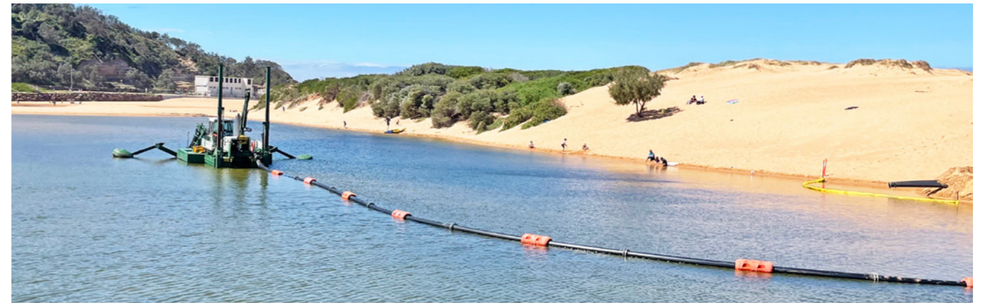
Proteger a la comunidad local de las inundaciones de forma inteligente. Las dragas Watermaster bombearon la arena acumulada directamente a la orilla de una sola vez
