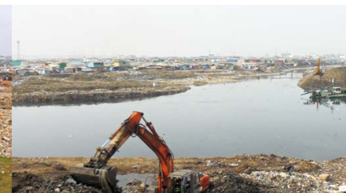
APRÈS restauration Environnement plus propre et plus sain, meilleur débit d’eau, moins de risques d’inondations
