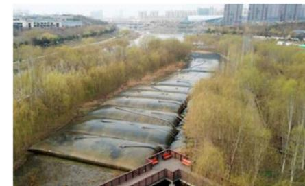
*Deshidratación con tubos geotextiles*
