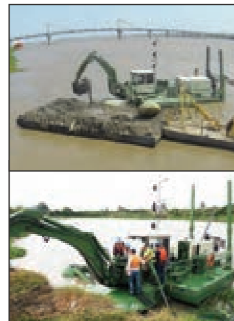
Сверху: очистка устья водозабора Снизу: обучение новых операторов
